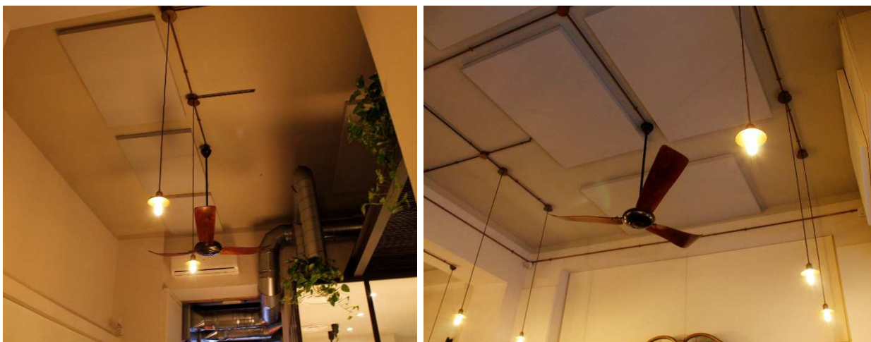
Figura n°4. Installazione dei pannelli fonoassorbenti al soffitto.
