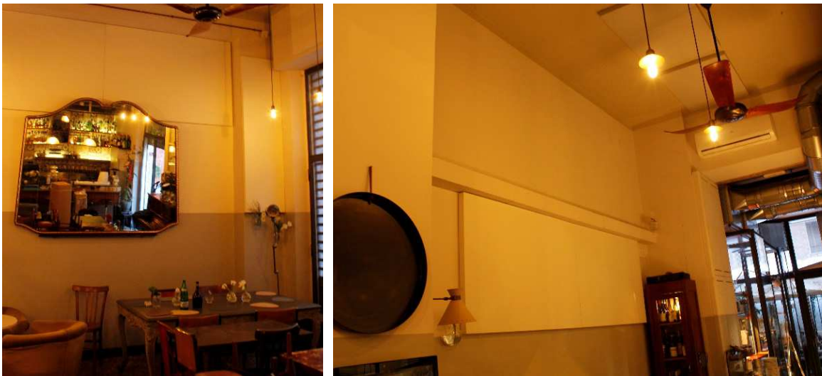
Figura n°5. Installazione pannelli fonoassorbenti a parete.
